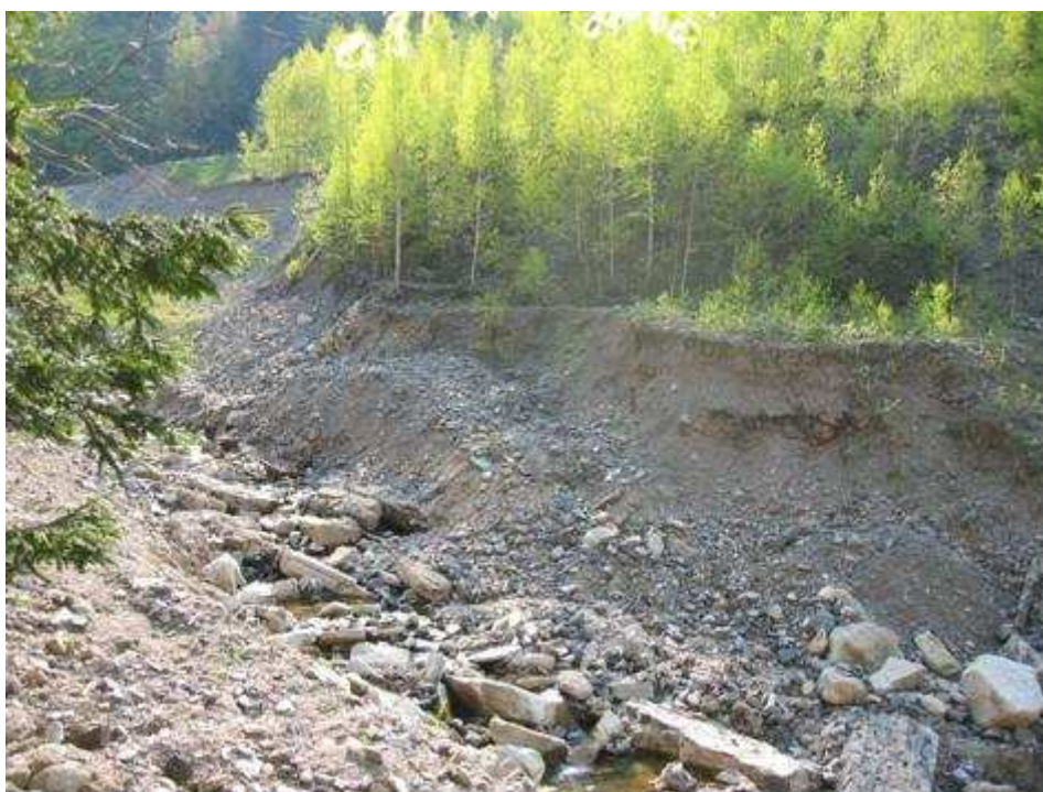
Rys.7. Niestabilne i narażone na erozję zbocze hałdy przy sztolni Nr 19 (gmina Kowary, Nr 03024 – 03028)
