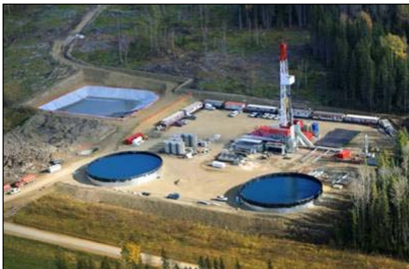
Ryc. 28 Teren wiertni z przykładowymi zbiornikami na wodę oraz płyn zwrotny [www.layfieldenvironmental.com].
