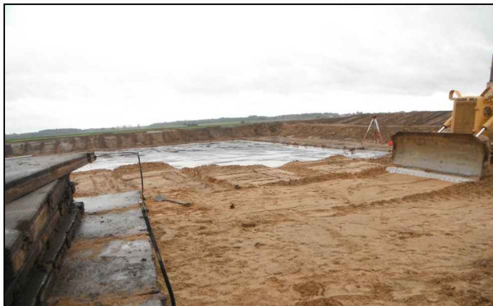
Ryc. 10 Montaż płyt betonowych na terenie wiertni – odwiert Siciny 2.
