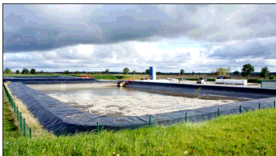
Ryc. 27 Przykładowy ziemny zbiornik na wodę lub płyn zwrotny [Koniecznyńska M. I inni, 2011].
