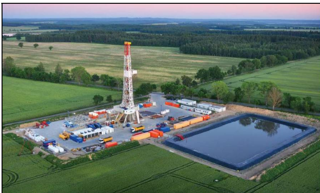
Ryc. 12 Przykładowa wiertnia wraz ze zbiornikiem ziemnym na wodę [źródło: Jakiel M. , Potera J., 2011].
